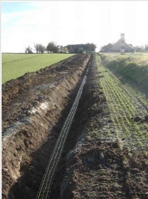
Abbildung 47: Erdverlegte, einfach geführte Gasleitung (5 bar).
