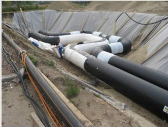
Abbildung 46: Erdverlegte, doppelt geführte Fernwärmeleitung
