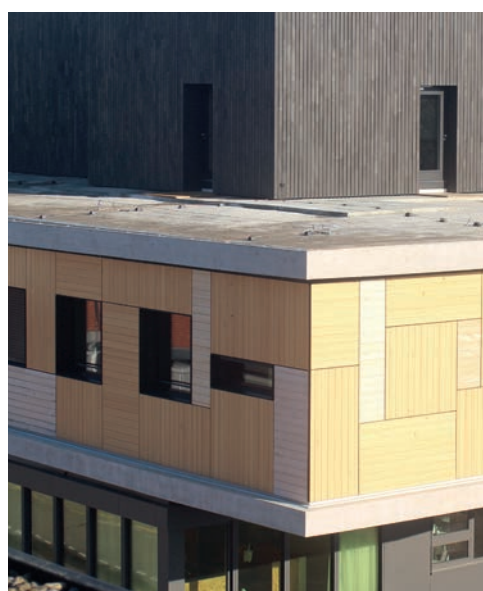
III. 15a Suivi à long terme des revêtements de surface comprenant des NFC, utilisés sur le module «Vision Wood» du bâtiment expérimental NEST de l'Empa à Dübendorf.
