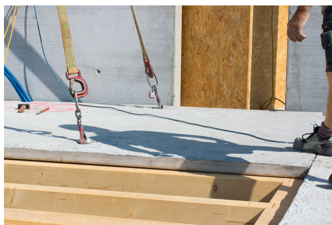
Holz-Beton-Verbund mit aufgeschraubten Beton-Fertigteilen Quelle: Häring Projekt AG
